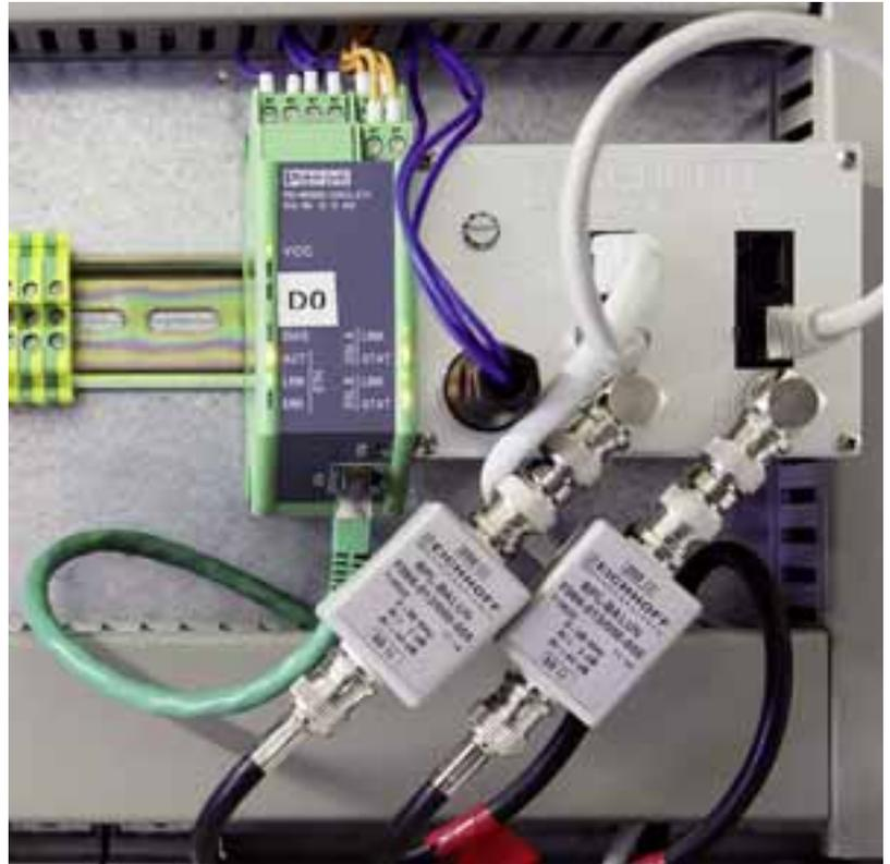
**Powerline:** Bei längeren Strecken oder einer erhöhten Störanfälligkeit können Filter wie diese von Eichhoff den Signal-zu-Rauschabstand um bis zu 20 dB verbessern und so die Reichweite bzw. Bandbreite deutlich steigern.
